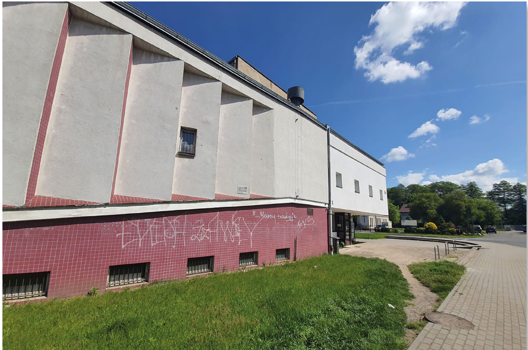
Przykłady budynków archiwów państwowych wymagających modernizacji
