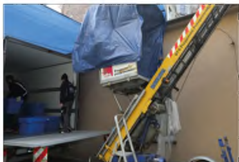
Archiwum Narodowe w Krakowie – zewnętrzna winda pozwoliła na zwiezenie z wyższych kondygnacji akt umieszczonych w plastikowych skrzynkach bezpośrednio do podstawionego samochodu ciężarowego
