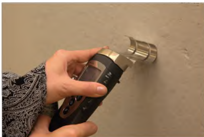
Badanie powierzchniowe wilgotności ścian za pomocą miernika wilgotności materiałów budowlanych
