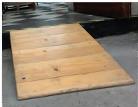
Drewniana pochylnia dla wózków transportowych (Archiwum Narodowe w Krakowie)
