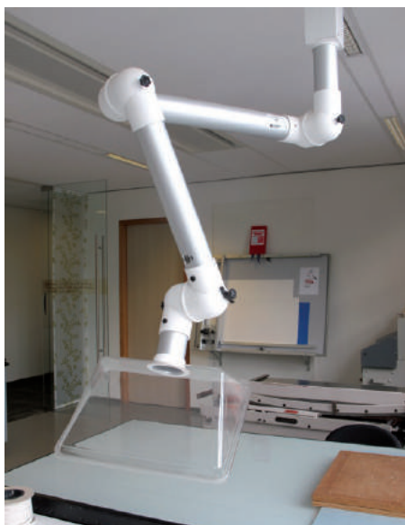
Wyciąg stanowiskowy nad stołem roboczym pracowni zabezpieczania archiwaliów. Archiwum Regionu Rivierenland w Tiel (Regionaal Archief Rivierenland), Holandia
