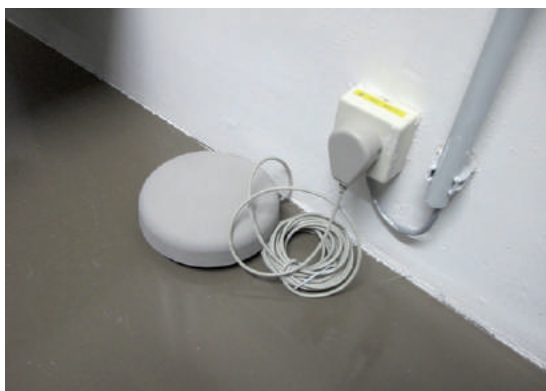
Czujnik systemu wykrywania wycieków wodnych w magazynie. Archiwum Regionu Rivierenland w Tiel (Regionaal Archief Rivierenland), Holandia
