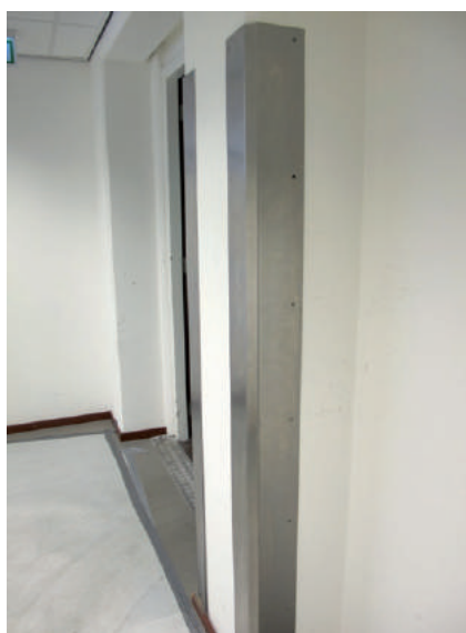
Zabezpieczenie krawędzi ścian korytarza wykonane ze stali nierdzewnej. Archiwum Narodowe Holandii w Hadze (Nationaal Archief), Holandia
