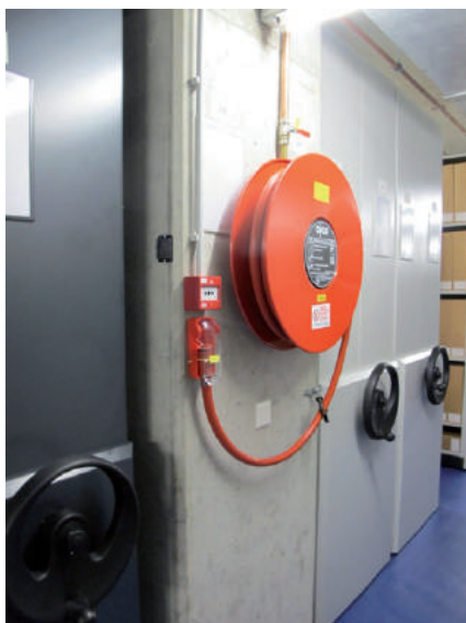
Pion hydrantu z zaworami na klatce schodowej w części magazynowej. Brandenburgskie Główne Archiwum Krajowe w Poczdamie (Brandenburgisches Landeshauptarchiv), Niemcy
