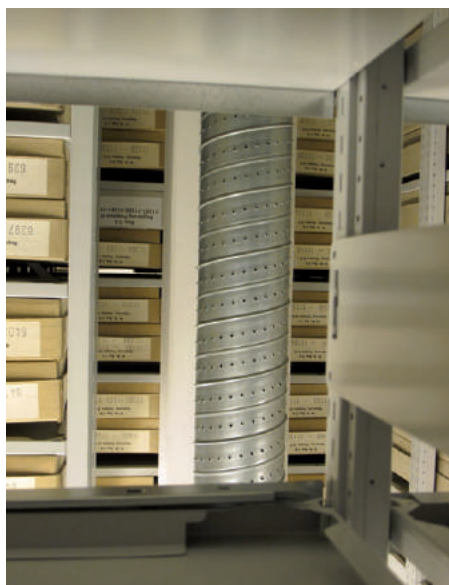
Pionowe perforowane przewody wentylacyjne zapewniające nawiew w magazynach.
