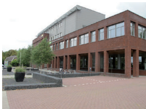
Parking dla niepełnosprawnych zlokalizowany w pobliżu rampy do wejścia do budynku. Archiwum Regionu Rivierenland w Tiel (Regionaal Archief Rivierenland), Holandia
