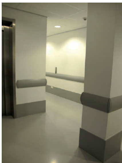
Korytarz części magazynowej z zabezpieczeniami ścian przed uszkodzeniem przez wózki transportowe. Brandenburgskie Główne Archiwum Krajowe w Poczdamie (Brandenburgisches Landeshauptarchiv), Niemcy
