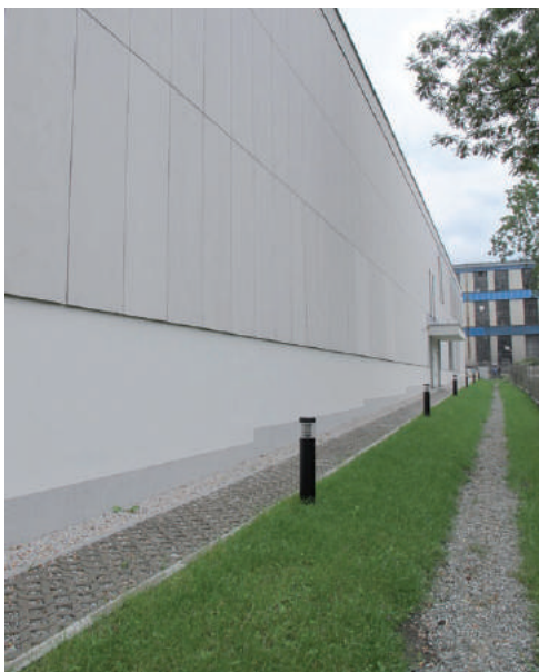
Opaska betonowa (min. 0,5 m) wokół budynku chroni przed wilgocią oraz szkodnikami. Archiwum Państwowe w Katowicach, Oddział w Bielsku-Białej
