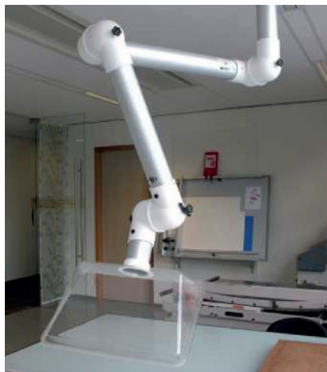
Wyciąg stanowiskowy nad stołem roboczym pracowni zabezpieczania archiwaliów. Archiwum Regionu Rivierenland w Tiel (Regionaal Archief Rivierenland), Holandia
