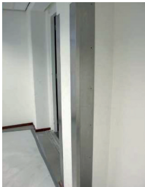
Zabezpieczenie krawędzi ścian korytarza wykonane ze stali nierdzewnej. Archiwum Narodowe Holandii w Hadze (Nationaal Archief), Holandia
