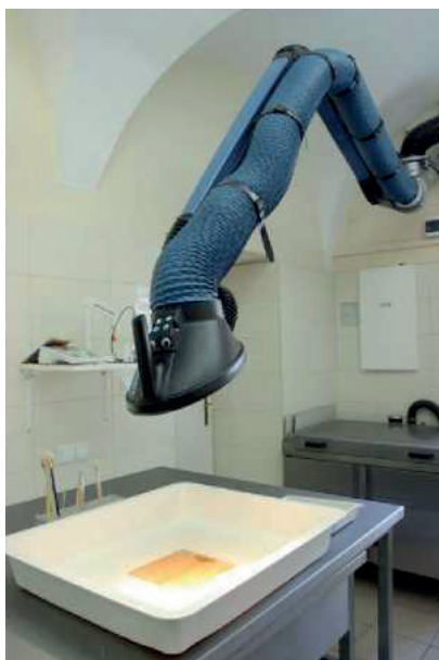
Wyciąg stanowiskowy do pracy nad rozpuszczalnikami w pracowni mokrej Centralnego Laboratorium Konserwacji Archiwaliów. Archiwum Główne Akt Dawnych w Warszawie
