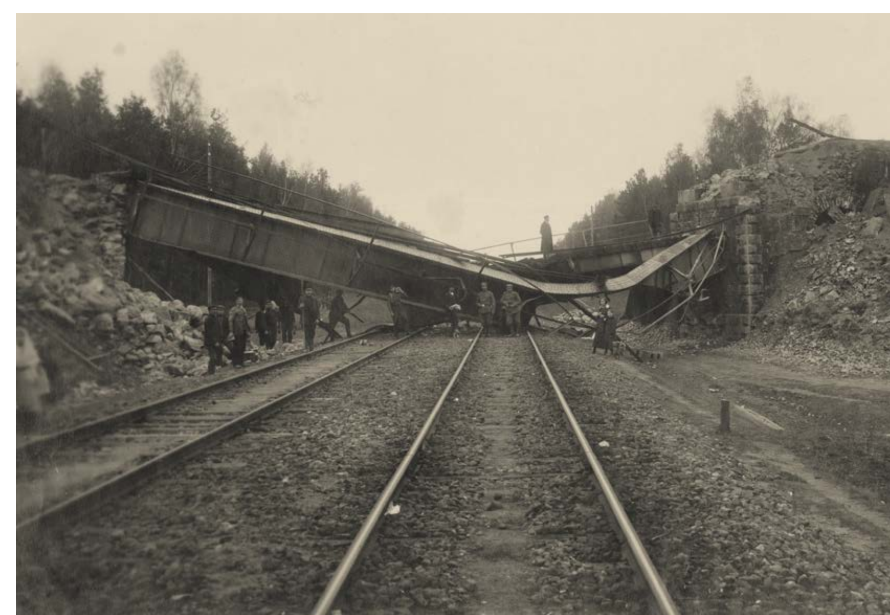
Wysadzony wiadukt kolejowy pod Koluszkami, 1915, b.a. (Archiwum Państwowe w Łodzi, sygn. 39/548/5850)
